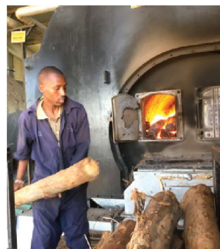
Teplantagerna eldar meterved av eukalyptus för att torka tebladen. En installation on 10 000 m 2 solfångare skulle täcka 50% av energibehovet och ersätta 100 hektar plantageskog.
