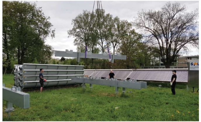
Teamet från Absolicon behövde bara tre dagar för att installera Absolicons solföljande solfångare i Graz.
